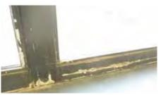
Figure II.1.101: corrosion steel door frame.
